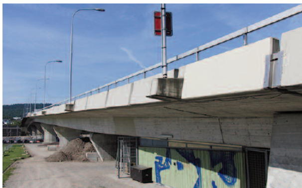
Testbrücke: Hermetschloo Brücke in Zürich. Test bridge: Hermetschloo Bridge in Zurich.
