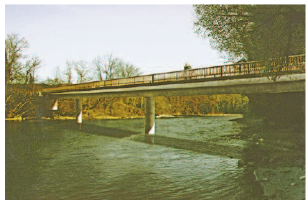
Stahlbetonbrücke im Gnadenthal.
