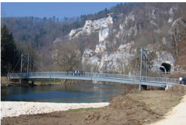
Seilverspannte Stahlbrücke bei Gutenstein, Donautal.
