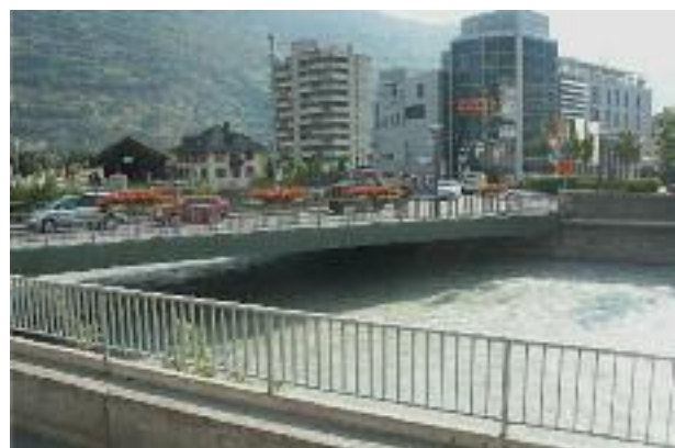
Heutige Landbrücke in Visp.
