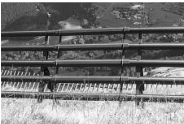
Lawinenverbauung in Davos. Foto E. Sabiote.
