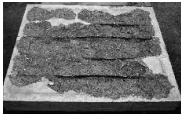
Hochfeste Betonplatte (1.1 m · 0.9 m) ohne Brandschutzbeschichtung nach 30 min ISO-Beflammung mit Abplatzungen. Spalling of high-performance concrete slab (1.1 m · 0.9 m) without fire protection after 30 min ISO fire exposure.
