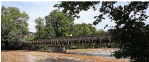
Reussbrücke (stromabwärts) von Gnadenthal Richtung Stetten blickend.
