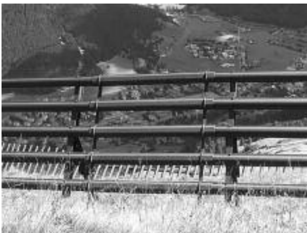
Stützwerke oberhalb Davos. Protection structures above Davos. (Foto E. Sabiote)
