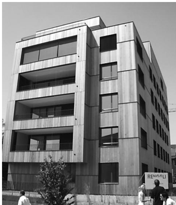
Erstes 6-geschossiges Holzgebäude in Steinhausen. First 6-storeys timber building in Steinhausen.
