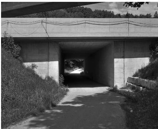
Typische Rahmenbrücke auf der Nationalstrasse A1. A typical frame bridge structure on the motorway A1.
