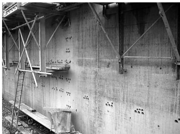
Experimentelle Bestimmung der räumlichen Variabilität verschiedener Betoneigenschaften an einem neu gebauten Tunnel in der Nähe von Opfikon, Schweiz.
