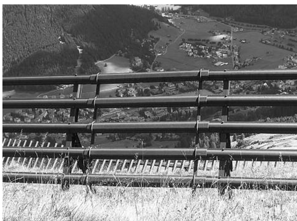
Stützwerke oberhalb Davos. (Foto E. Sabiote) Protection structures above Davos. (Foto E. Sabiote)
