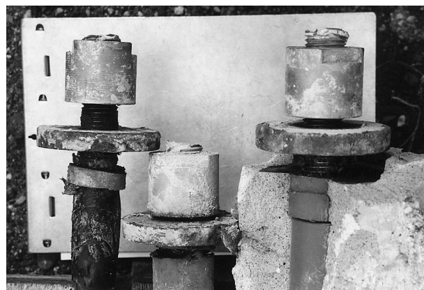
Zustand nachträglich eingebauter vertikaler Zugstangen bei einem kurzen Endfeld eines Dreifeldträgers. Condition of supplementary vertical tie rods attached to a short side span of a multispan girder.
