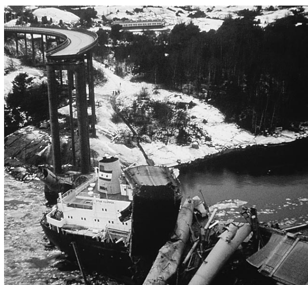
Tjörn Brücke nach Schiffskollision Tjörn Bridge after ship impact (Foto S. Thelandersson)
