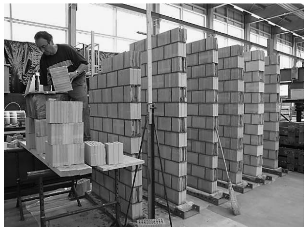
Aufmauern der Prüfkörper in der Bauhalle.
