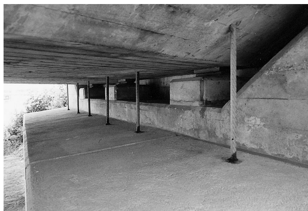
Zustand nachträglich eingebauter vertikaler Zugstangen bei einem kurzen Endfeld eines Dreifeldträgers. Condition of supplementary vertical tie rods attached to a short side span of a multispan girder.
