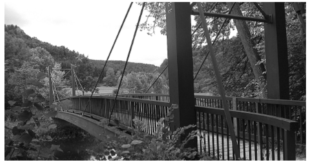
Gruppe 2: Seilverspannte Brücke beim Käpfletunnel.
