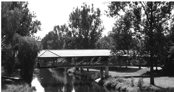
Gruppe 1: Fachwerkbrücke Fridingen.
