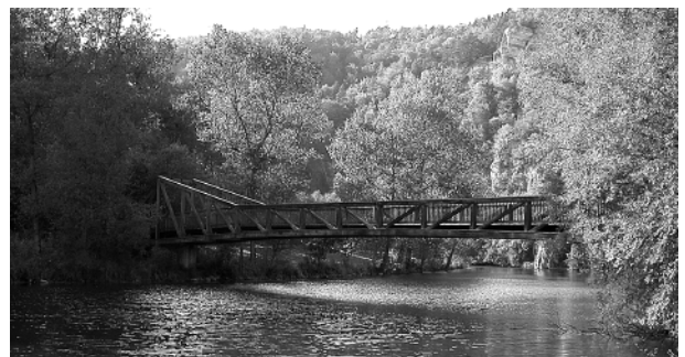
Gruppe 4: Fachwerkbrücke beim Teufelsloch.
