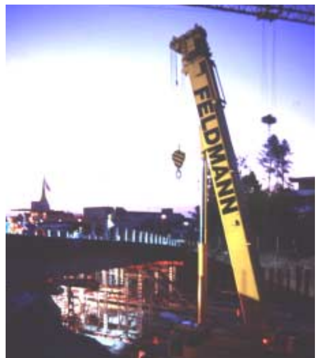
Auflad der zersägten Teilstücke der Überführung Burggasse Altendorf SZ.
