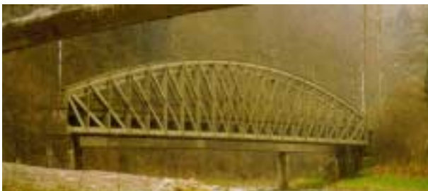
Die 1896 gebaute Bahnbrücke über die Sihl.
