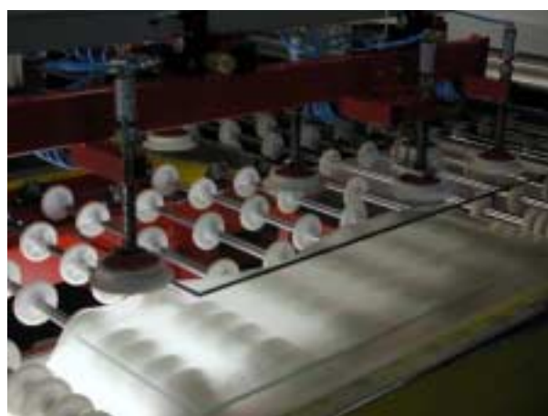
Herstellung der VSG Scheiben in Vorverbund für die Vierpunktbiegeversuche.
