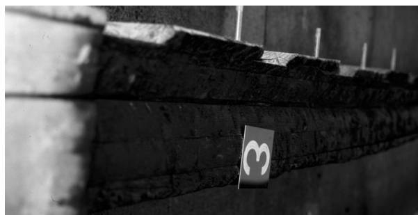
Leimversagen der Fuge einer Holz-Beton-Verbunddecke mit Balken.
