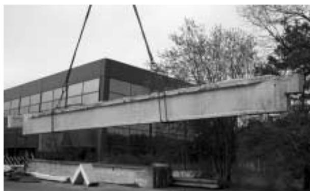
Träger T9 beim Umsetzen auf den Belastungsstand.
