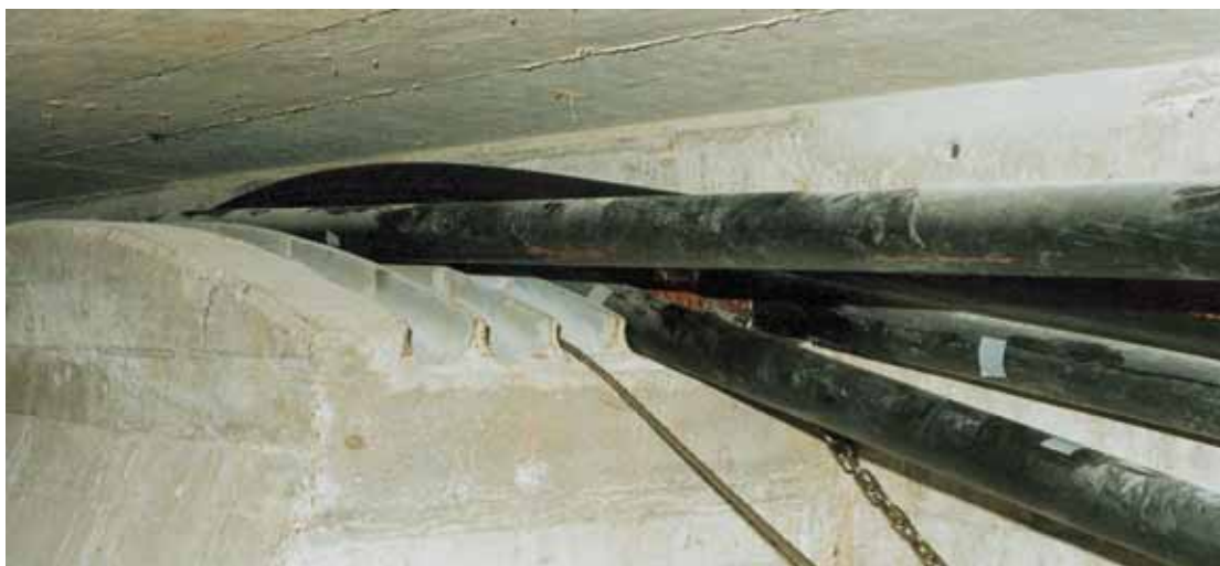
Aussenliegende Vorspannung
