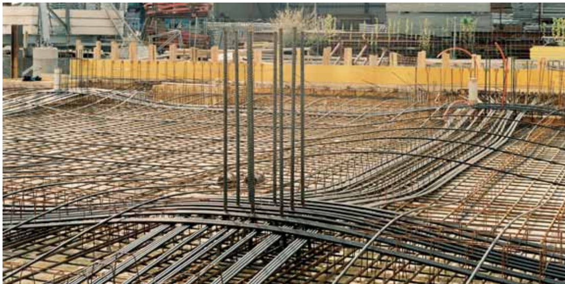
Flachdeckenvorspannung mit Stahlton-CONA Monolitzenspannglieder ohne Verbund
