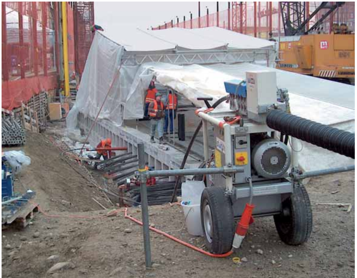
Einstossgerät im Einsatz am Hauptbahnhof Zürich
