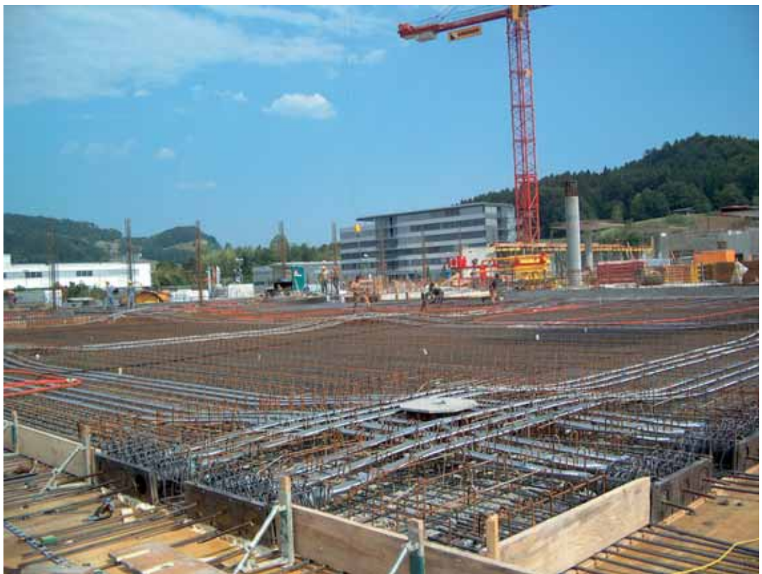
Stahlton-Stützstreifenvorspannung für eine Flachdecke
