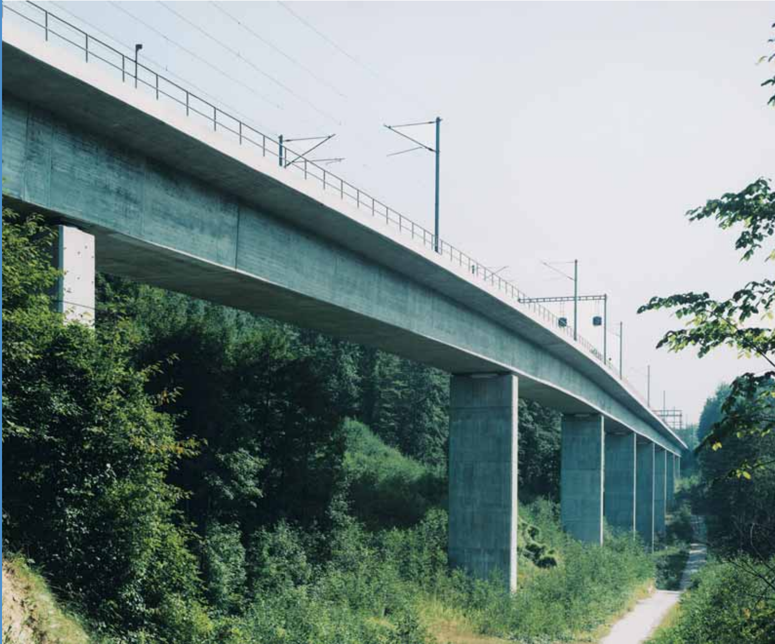
SBB-Brücke im Galgentobel, St. Gallen
