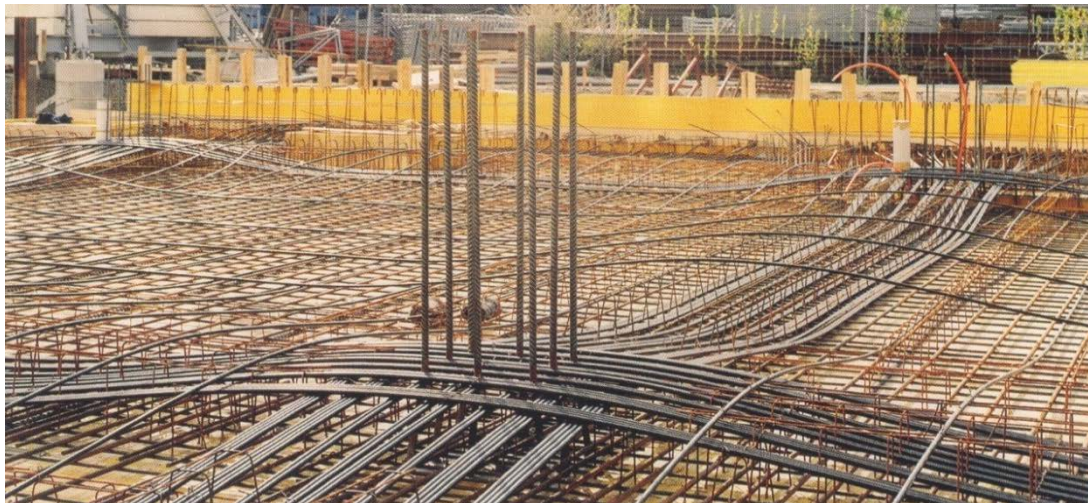
Deckenvorspannung mit Monolitzen (Foto: Stahlton AG)
