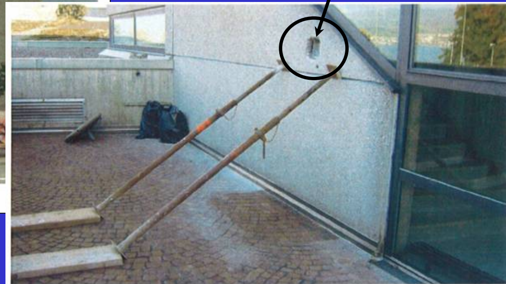
Stelle der "Ankerentnahme" (Nordfassade)
