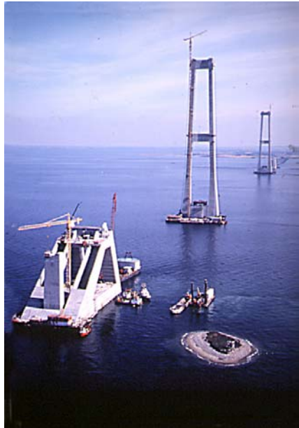
Grosse Belt Brücke während des Baus
